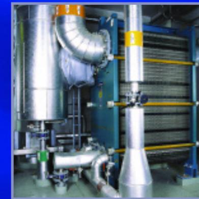
Existem diversos tipos de trocadores de calor a placas. Na aparência, eles são semelhantes, mas no interior é que estão as diferenças. Para cada necessidade se aplica um conjunto de placas e vedações.
